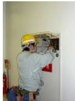
防災システムの施工
