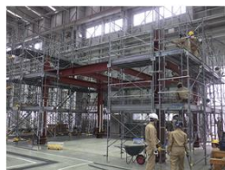
実習で施工したモデル建物
