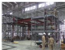
実習で施工したモデル建物
