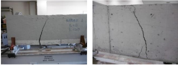
図 11 B 上ひび割れ 図 12 B 下ひび割れ
