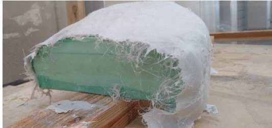
図 13 FRPによる外装制作の様子
