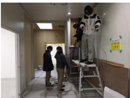
写真 6 現場施工状況
