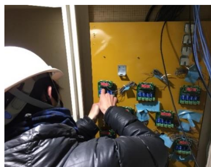
写真 7・8 ひずみユニット施工状況
