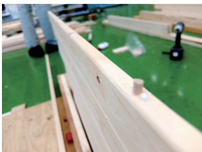
図4 取付けられたダボ
