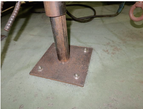
図 6 アンカーにて固定
