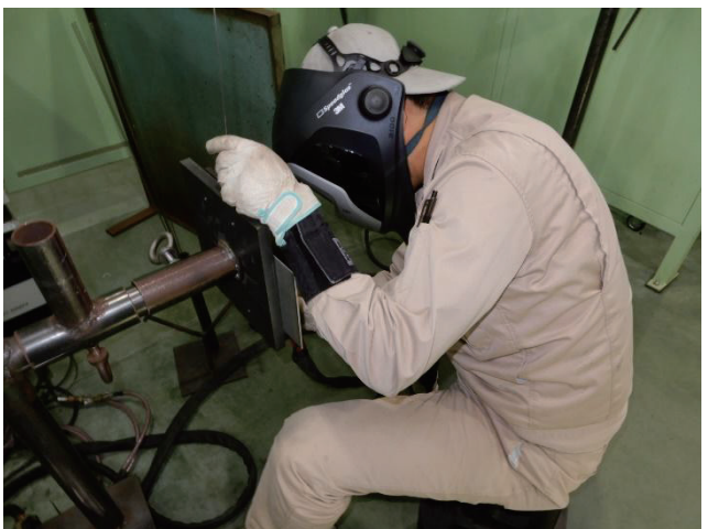
図 13 TIG 溶接立向き溶接作業例
