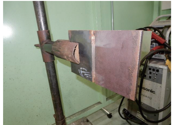
図 10 手・半自動溶接 立向固定例
