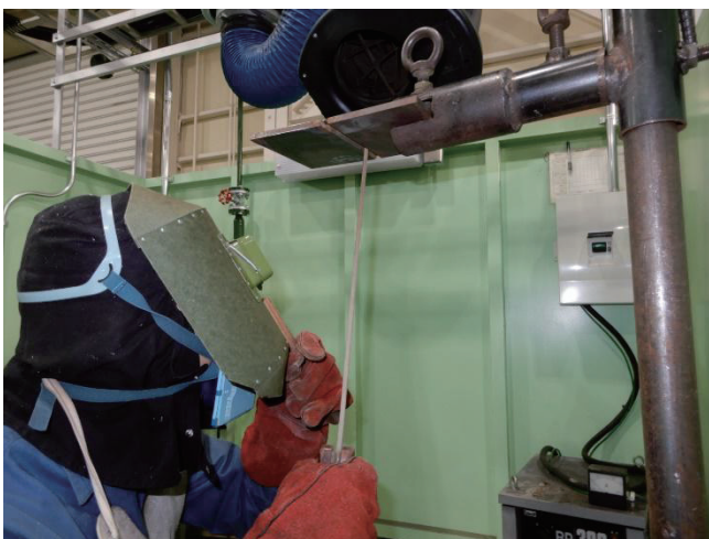
図 12 手・半自動溶接上向き溶接作業例
