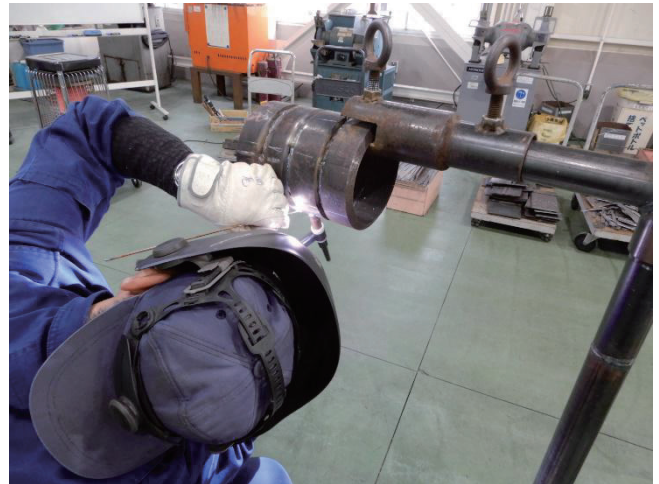
図 14 配管溶接作業例
