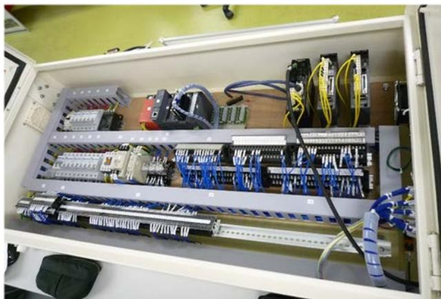
(b) 製作した制御盤である。全体的にはよくできているように見える。この盤ごとと負荷装置に設置する。動作しているようすは (c) をご覧ください。
