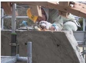
図2 小屋組み取り付け
