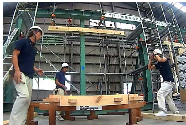
図6 耐力壁の組立
