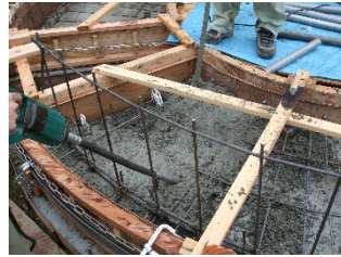
図15 締め固め
