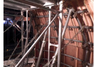
図28 建ち直し・固め
