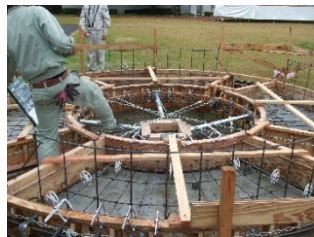
図14 型枠建て込み
