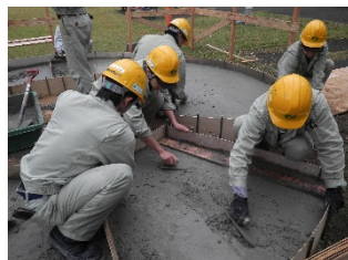
図4 捨てコンクリート地業
