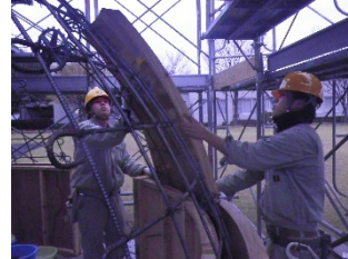
図27 型枠建て込み
