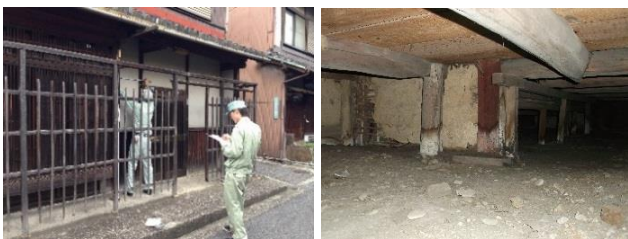
図 5 外部実測調査，床下状況の確認
