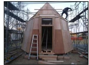
図13 外壁施工
