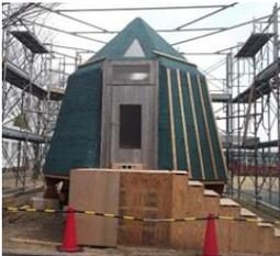
図 24 防水シート施工
