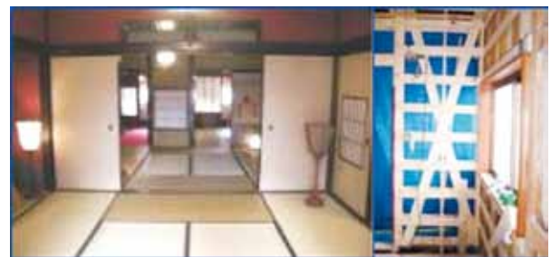
図1 開口部の多い間取りと壁の増設工事例
