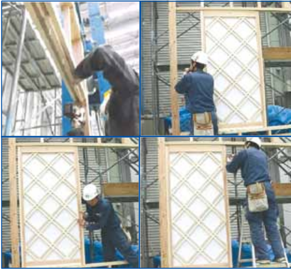
図9 実験用建具の取り付け
