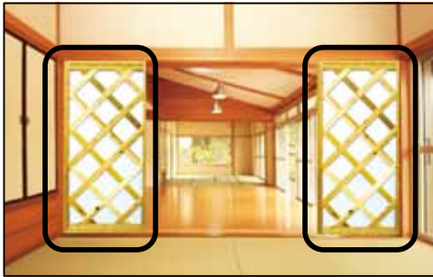
図2 耐震建具の取り付けイメージ
