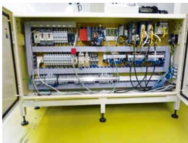
(b)制御盤組み立て例
