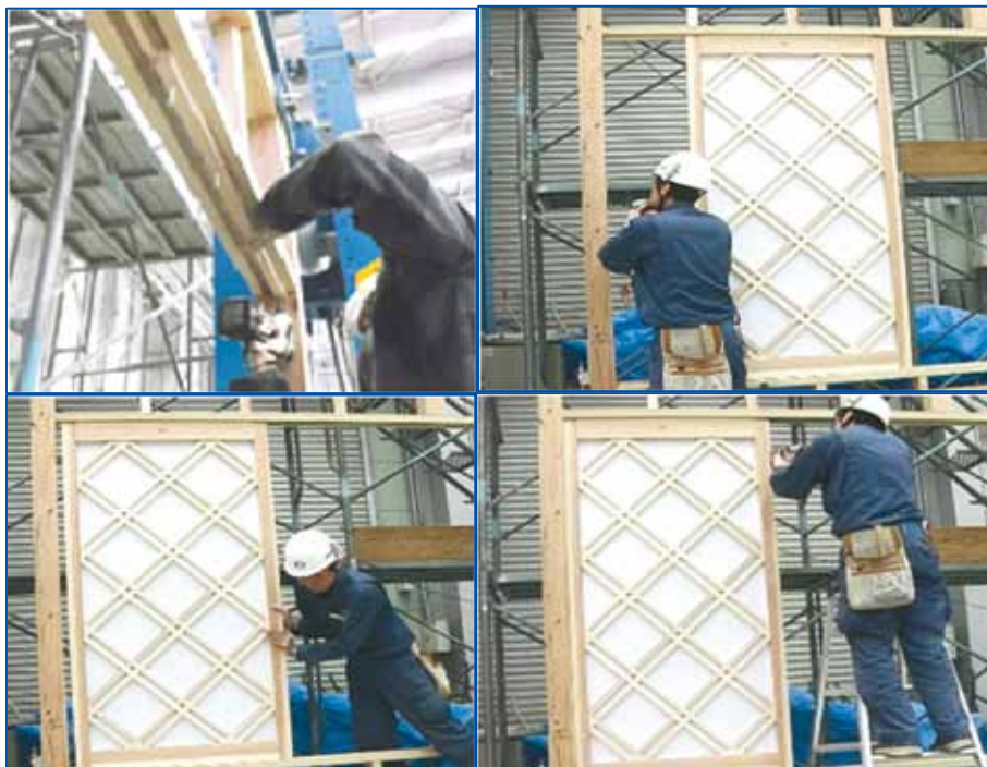
実験用建具の取り付け (p34)
