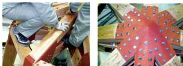
図 28 上り梁取付け 図 29 頂点金物取付け
