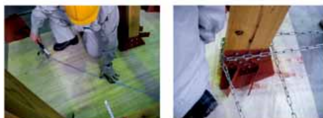
図 24 寸法の確認 図 25 ターンバックル取付け
