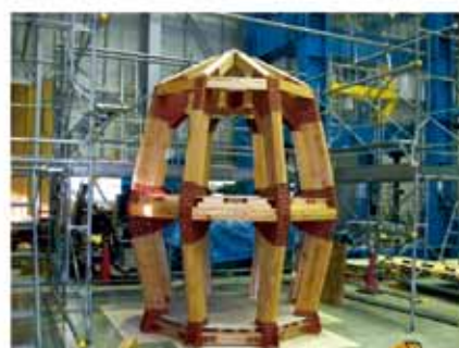
図 30 1/2 スケール施工の完成
