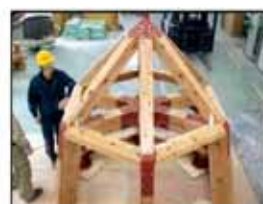
図3 ハニーロッジ 1/2 施工
