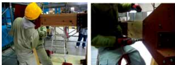
図 22 柱・梁調整 図 23 梁ボルト取付け
