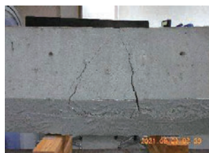
図16 有筋1試験体 ひび割れ(補強後)
