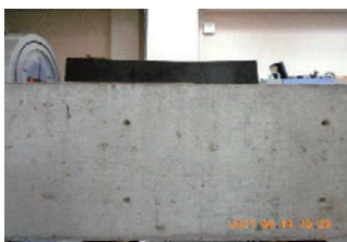
図15 有筋1試験体 ひび割れ(補強前)
