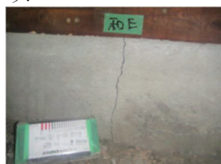
図1 基礎梁補強前
