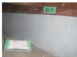
図2 基礎梁補強後
