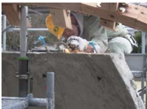
図2 小屋組み取り付け
