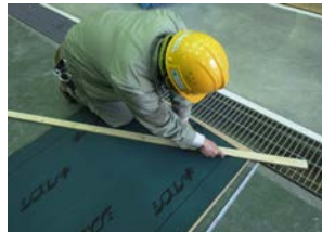
図3 屋根ルフィング加工
