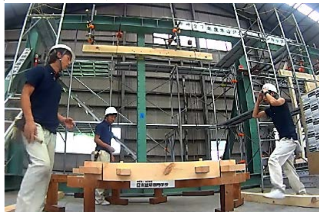
図 6 耐力壁の組立
