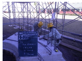
図19 2次元曲面配筋
