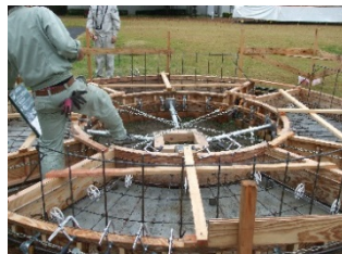
図14 型枠建て込み
