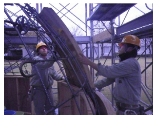
図27 型枠建て込み
