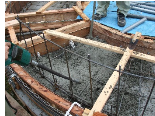
図15 締め固め
