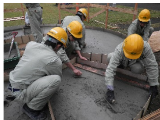
図4 捨てコンクリート地業
