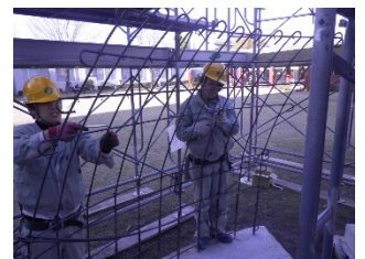
図20 3次元曲面配筋
