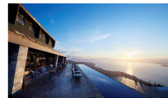
施工事例「びわ湖テラス」 ★私が1年目に担当しました！
