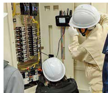
漏電探査実習
