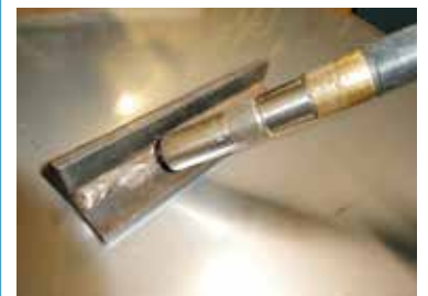
半自動アーク溶接
