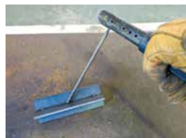
被覆アーク溶接
