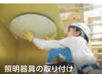
照明器具の取り付け
