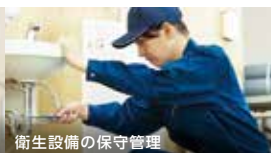
衛生設備の保守管理
