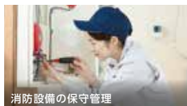
消防設備の保守管理
