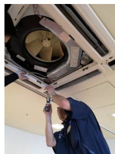
エアコン取付
