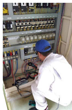
制御盤点検
