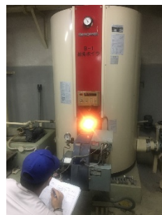
ボイラー点検
