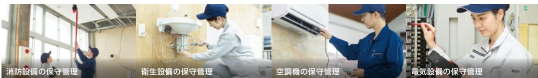
消防設備の保守管理
