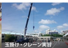
玉掛け・クレーン実習
