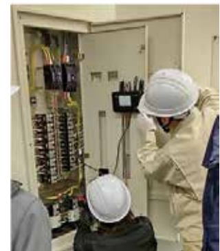
漏電探査実習
