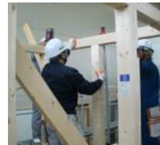
▲ 木造軸組加工法による建物組立の実習
