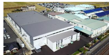
東江原工場全景
