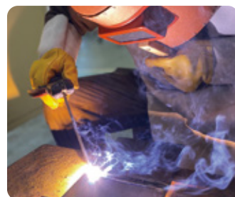
アーク溶接作業
