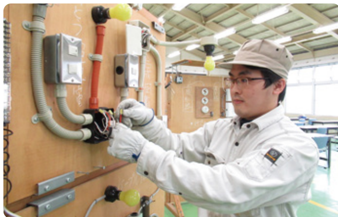
電気工事作業
