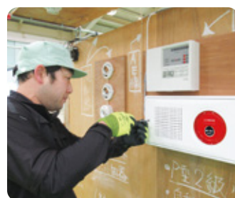
消防設備工事業業
