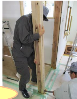
柱・壁の撤去
