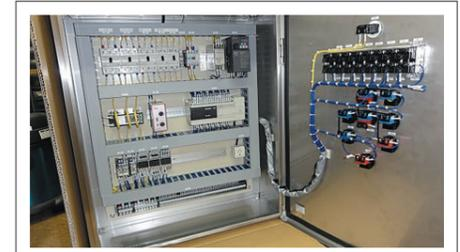
[安全検証制御盤実習装置]
