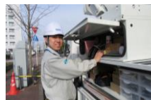
● 電気設備工事
