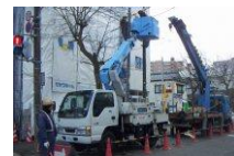
● 電気通信工事
