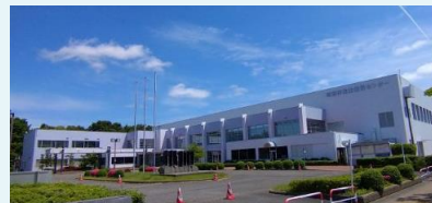
新潟市産業振興センター 大規模改修空調設備工事 令和3年度 新潟市優良工事表彰
