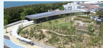
新潟市水族館 リニューアル衛生設備工事
