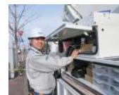
電気設備工事
