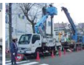
電気通信工事
