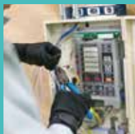
電気配線作業
