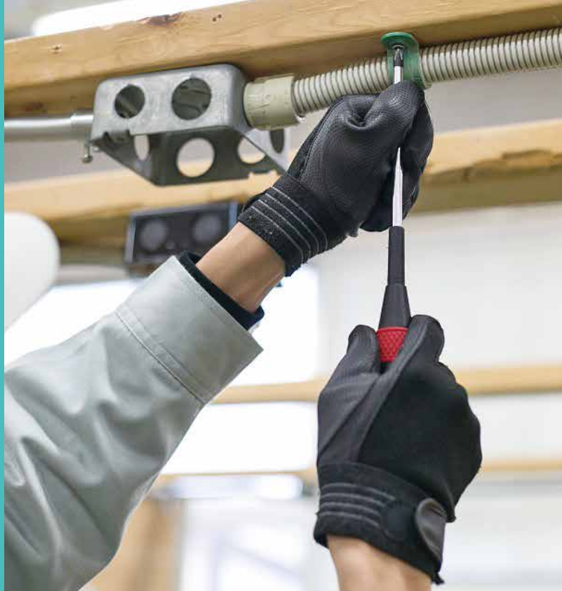
電気設備工事
