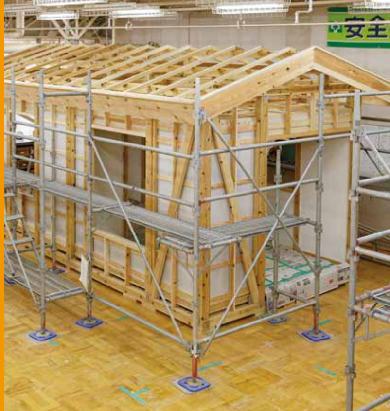
模擬家屋施工実習
