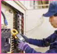
電気設備工事
