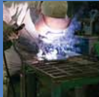
被覆アーク溶接
