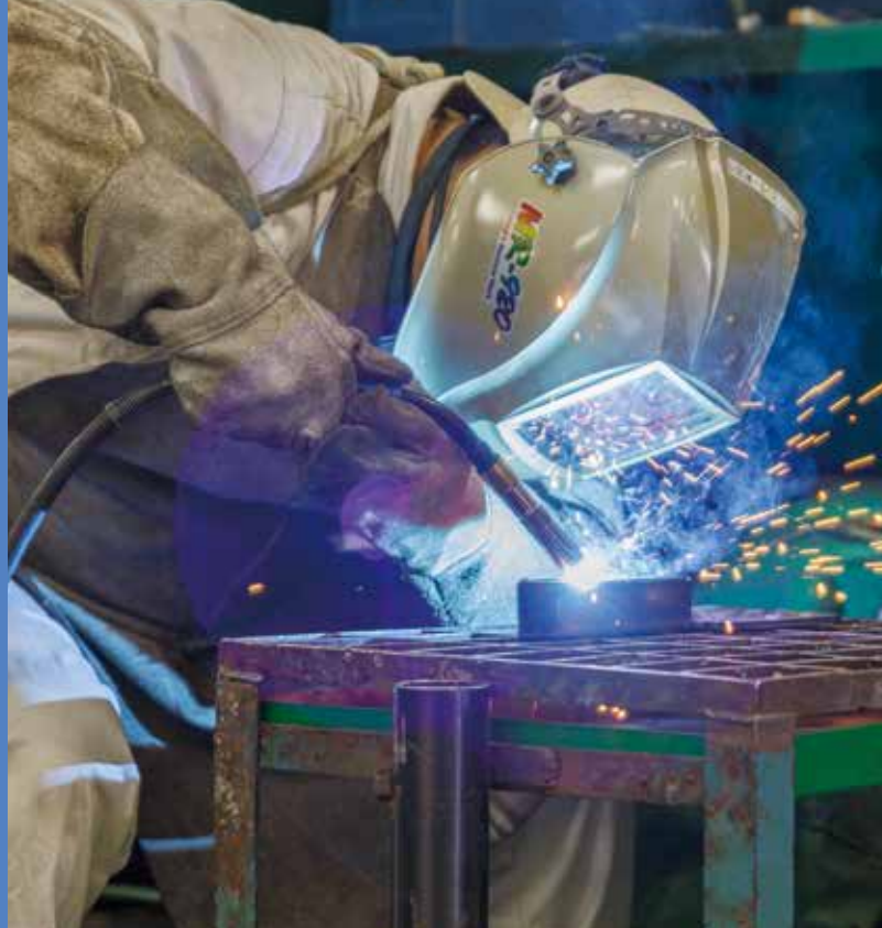
炭酸ガスアーク溶接
