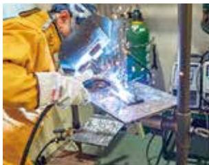
半自動アーク溶接作業
