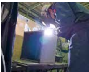
配電ボックスの溶接作業
