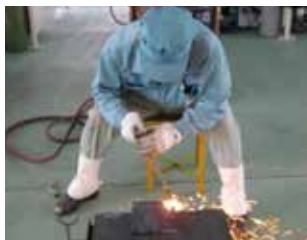
ガス切断作業
