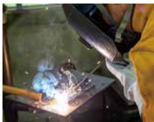
被覆アーク 溶接作業
