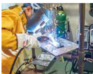
半自動アーク 溶接作業
