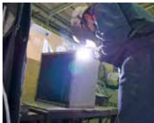
配電ボックスの溶接作業
