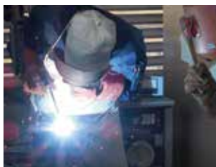
被覆アーク 溶接作業
