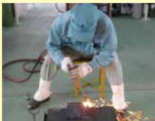
ガス切断作業
