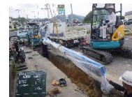
●上下水道本管の布設
