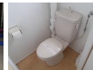
●住設機器の設置確認
