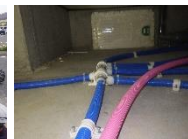
●住宅設備の配管施工
