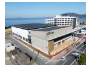
雲仙市新小浜体育館 (仮称) 新築工事
