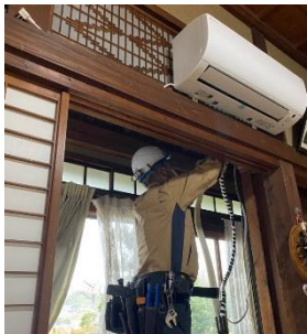
エアコン取付工事
