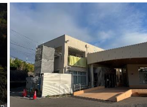
みさかえの園めぐみの家 改修工事
