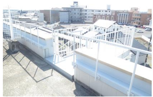
屋上への階段上り口
