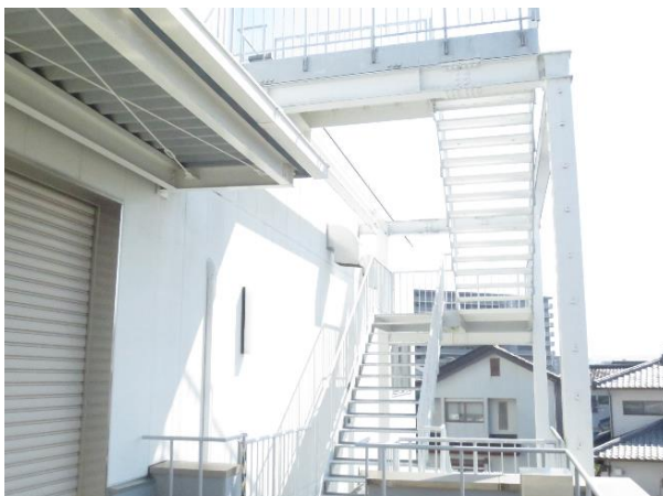
2F 非常口踊り場からの屋外階段
