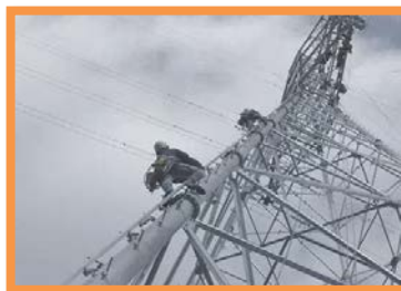
架空電線工事
