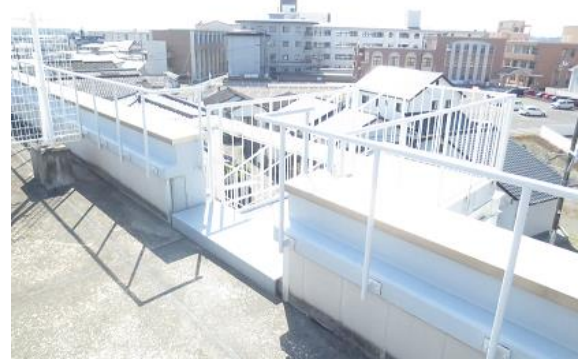
屋上への階段上り口
