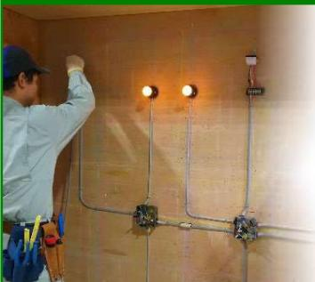
電気設備工事の施工で用いられる金属管や合成樹脂管などの各種管工事施工をして電気工事の設計、工事、試験、検査に関する技能及び関連知識を習得します。
