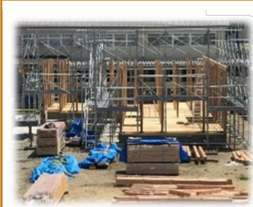
実際の建築現場と同様のプレカット工法による木造住宅の建て方工事を行います。骨組みが立ち上った後に、床を畳仕上げとする和室を施工します。
