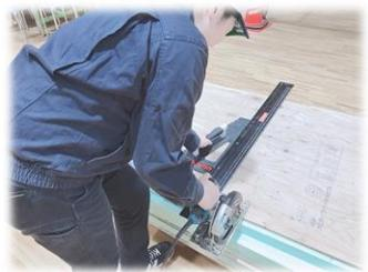
木造住宅の建築工事で使用される大工道具や電動工具の取り扱い方法について学びます。道具の使用の際の注意点、カン・コツまで一から細かく学びます。
