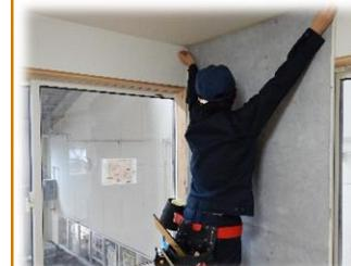
和室から洋室へのリフォームを行います。襖を引き戸に、畳をフローリングに変更し、天井・壁はクロス（壁紙）仕上げを行います。実践的な技術・知識を学びます。
