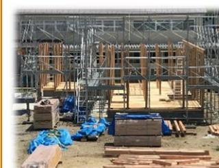
実際の建築現場と同様のプレカット工法による木造住宅の建て工事を行います。骨組みが立ち上った後に、床を畳仕上げとする和室を施工します。
